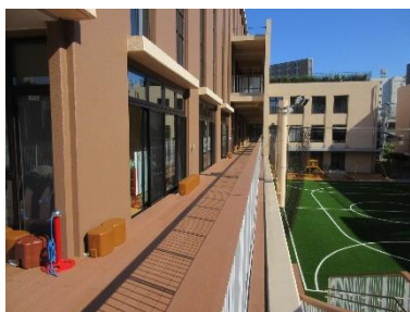
3、4、5歳の保育室に面しているテラス
